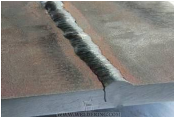
б) Продольная трещина на границе сплавления
