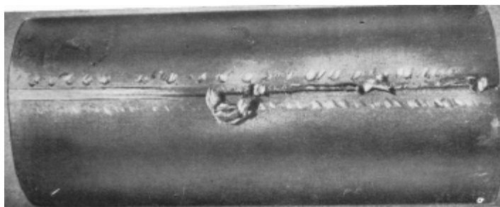
Рисунок 2 – Неснятые брызги металла на сварном шве
