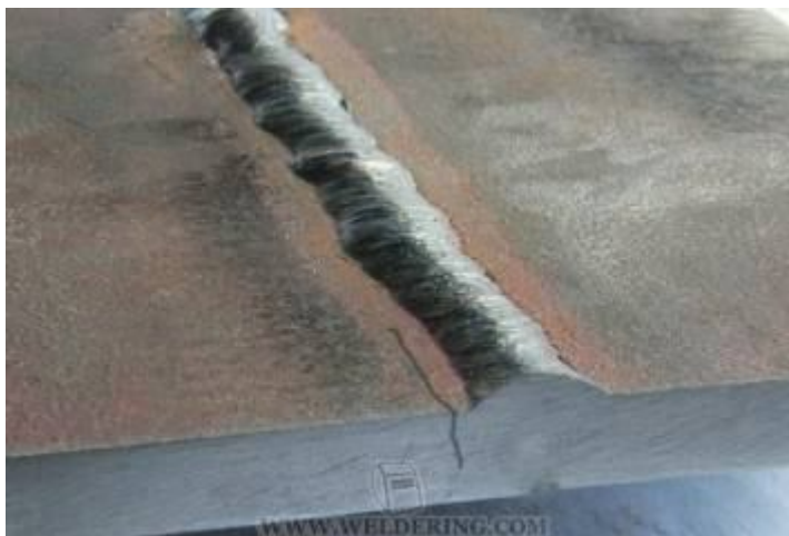
в) Продольная трещина в зоне термического влияния
