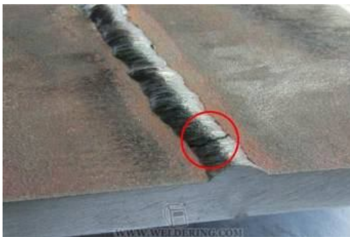
б) Поперечная трещина в металле сварного шва
