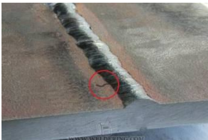
в) Поперечная трещина в зоне термического влияния
