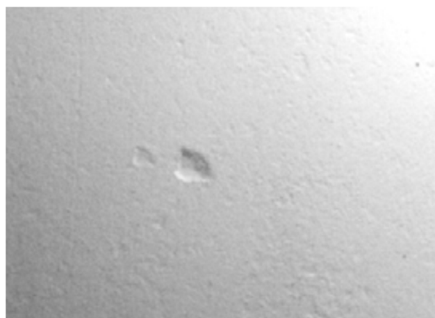
Рисунок А.17 – Точечная коррозия
